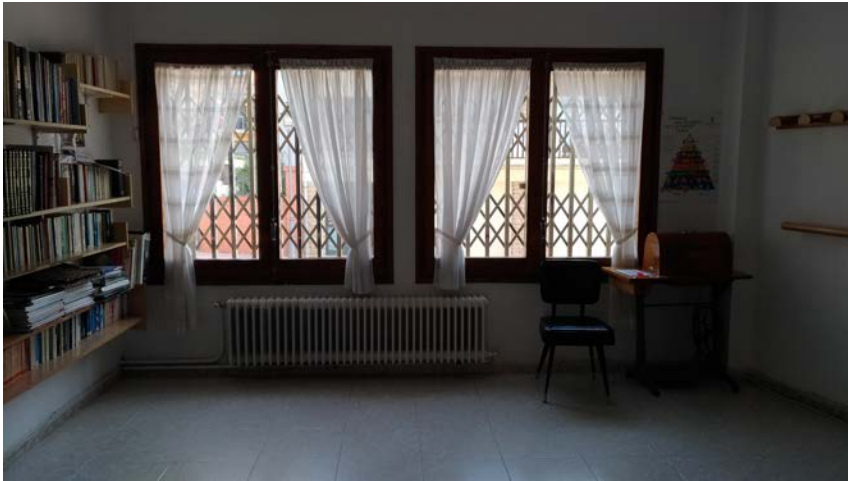
Finestres situades a la dreta (interior)
